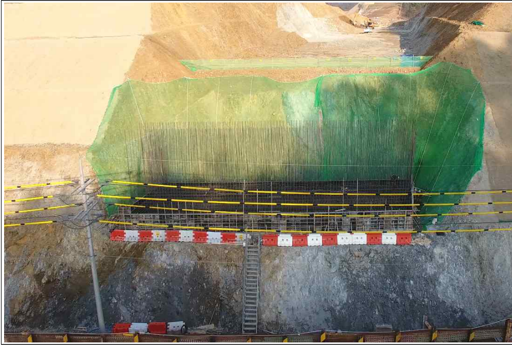
【그림 5】시점부 교대 시공사진
