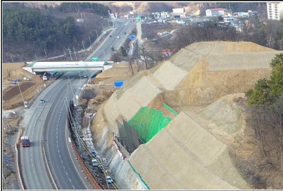
【그림 3】 깎기비탈면 시점부 측면 사진
