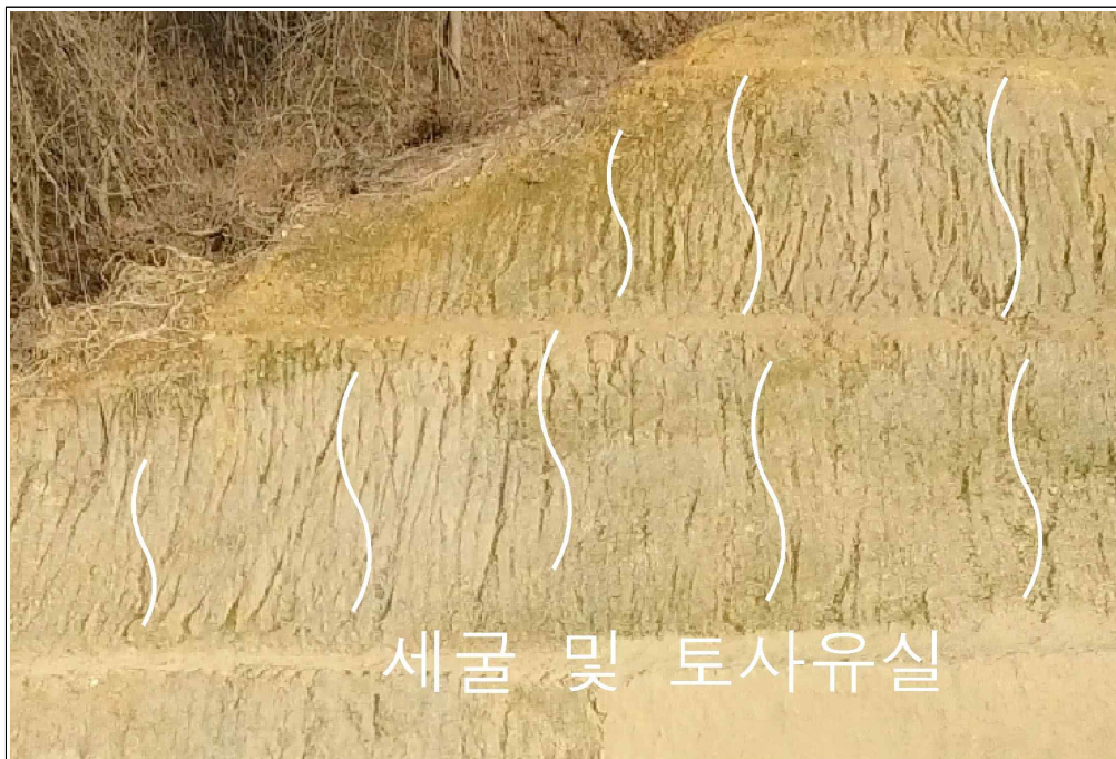
【그림 11】 A 영역에서 관찰된 세굴 및 토사유실
